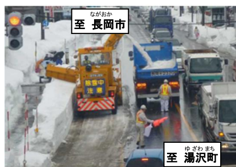
写真4-4 現道における運搬排雪作業状況（片側交互通行規制）
