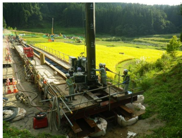
写真3-9 間垣地区の抑止杭工
