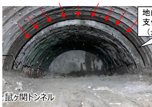
写真3-1 膨張性地山（鼠ヶ関泥岩）の出現
