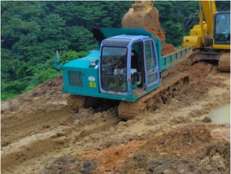
写真3-12 掘削状況 (第4種建設発生土相当)
