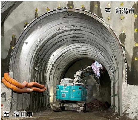
写真2-1 4号トンネル貫通状況 (R5.12 撮影)
