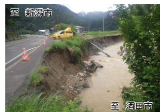
写真4-2 大雨による護岸崩壊 (村上市上大鳥 R4.8.4)
