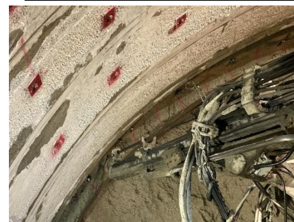
写真3-3 注入式長尺鋼管フォアボーリングの施工状況
