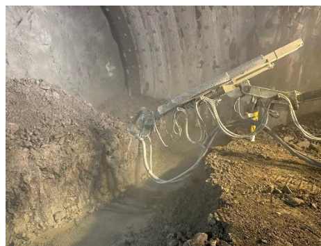
写真3-6 インバート吹付の施工例
