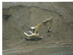
写真3-2 排土工の作業状況
