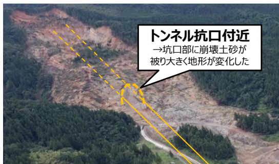
写真3-5 起終点坑口周辺状況
