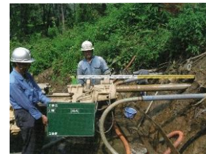
写真3-3 横ボーリング工の作業状況
