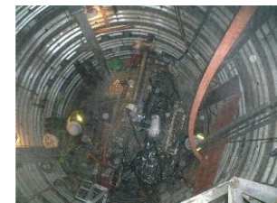
写真3-4 集水井の作業状況
