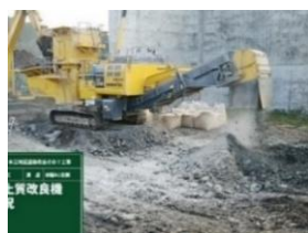
写真3-7 土質改良の作業状況
