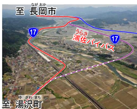
写真1-1 湯沢方面から 浦佐バイパスを望む
