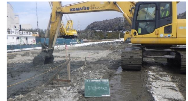
浚渫土砂の土質改良
