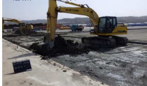
舗装施工前に路床の地盤改良が必要 (設計CBRの確保)
