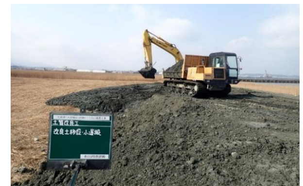
浚渫土砂の仮置き・乾燥⇒曝気
