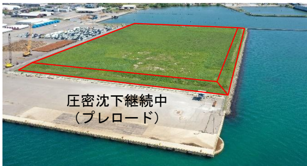
舗装施工前に路床の地盤改良が必要 (設計CBRの確保)
