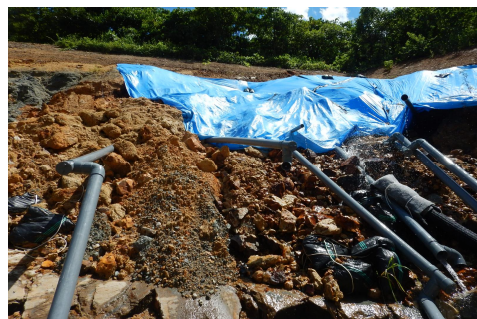
図3-7 大雨後の水抜きパイプの状況写真 (R6. 8. 19)
