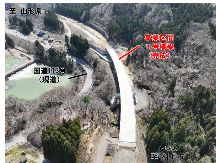
写真2-1 1号橋梁（R5完成）（大内渚地区）
