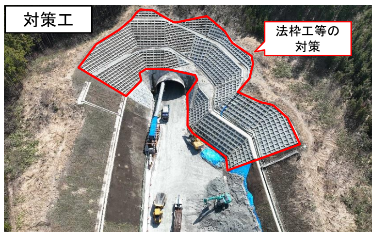
図3-5 対策工施工後の写真 (R6. 4. 5)
