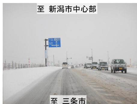
写真2-9 一般国道8号白根バイパス の交通状況 (開通後 R3. 1)
