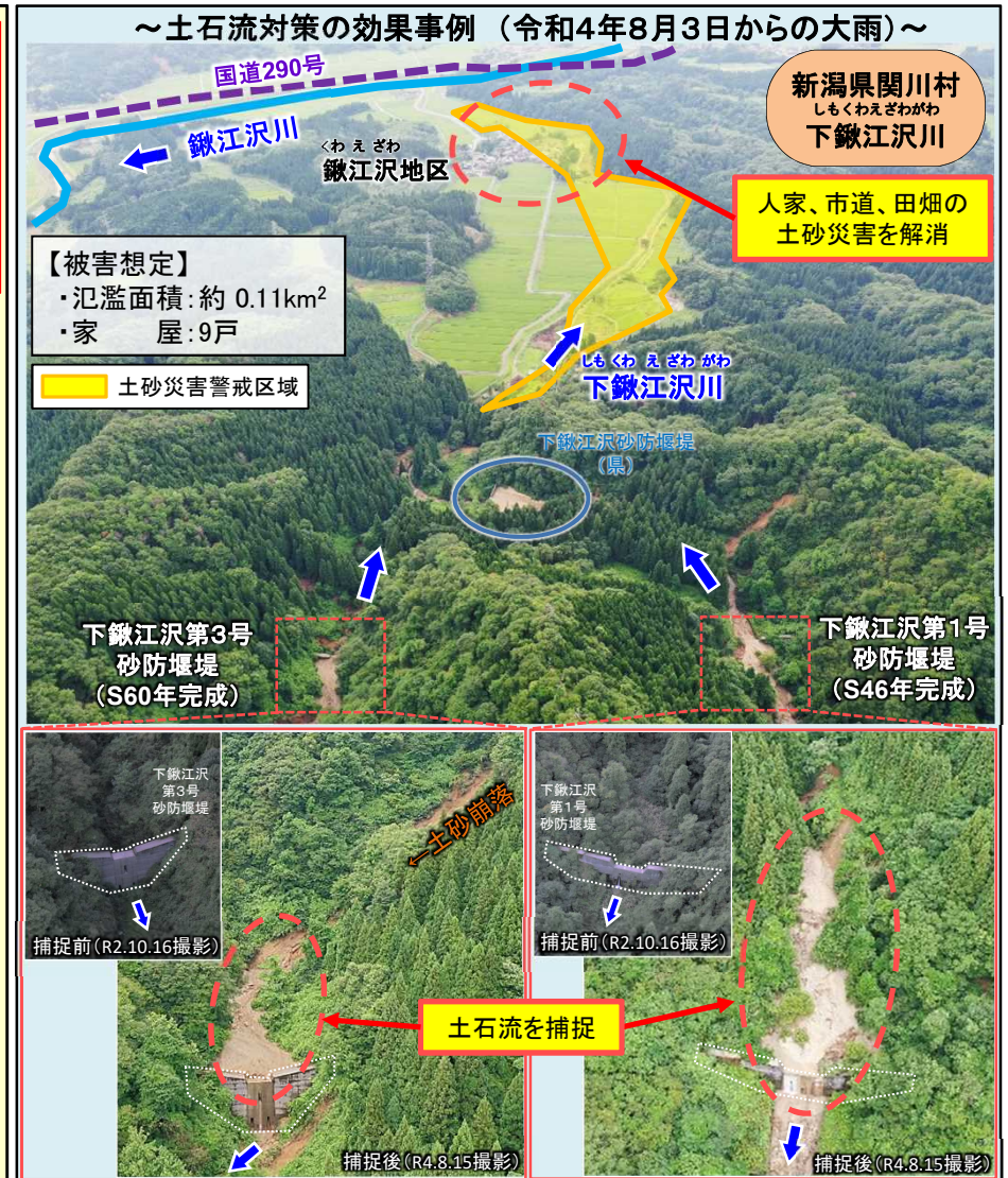
図2-4 土石流対策による直接被害の防止効果事例
