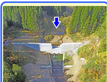
とどろがわ ⑩戸沢川砂防堰堤 <荒川流域> H30年度完成
