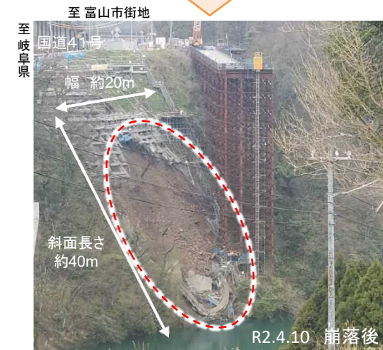
写真3-2 崩落後の状況
