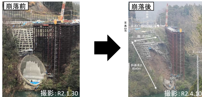
写真3-3 崩落状況
