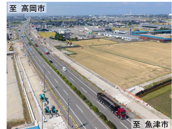
写真2-2 改良工事の進捗状況 (R4. 9) (富山市小西地先)
