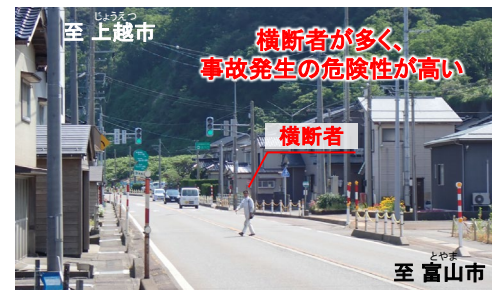
写真2-3：国道8号を横断する歩行者（糸魚川市間脇付近）
