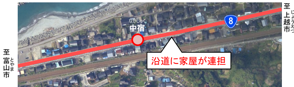
写真2-6：沿道に家屋が連続する区間
