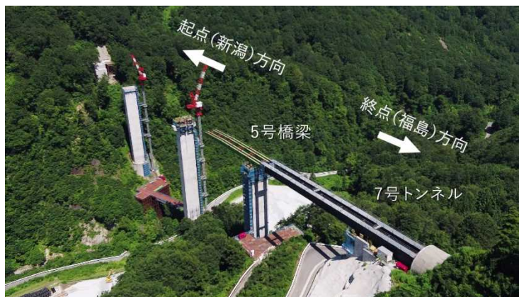
写真2-1 7号トンネルから5号橋梁を望む
