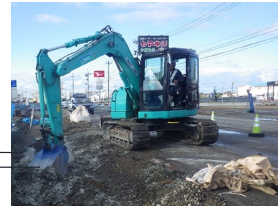
路床改良施工状況
