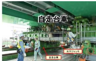
桁を押し出すために必要な装置。通常のジャッキでの送り出しと比べて、送り出す速度が速い。
