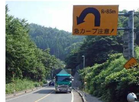
写真4-5 現道区間の線形不良箇所
