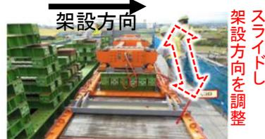
曲線がある橋の送り出しに用いられる装置。桁を一定距離送り出した後、橋軸直角方向へスライドさせる。
