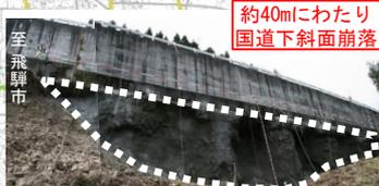
写真②：岩稲地区の国道下斜面崩落（H22. 3. 9）
