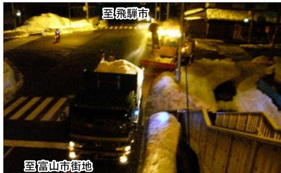
写真②：路肩確保のための運搬排雪作業
