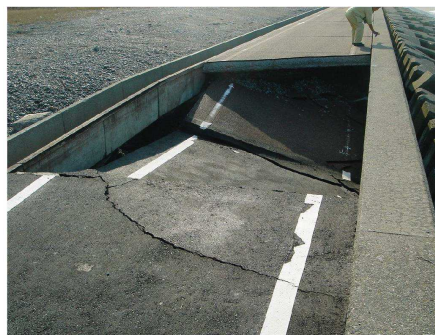
写真1-4 堤防空洞化による天端陥没状況 (平成19年11月 片山津工区)
