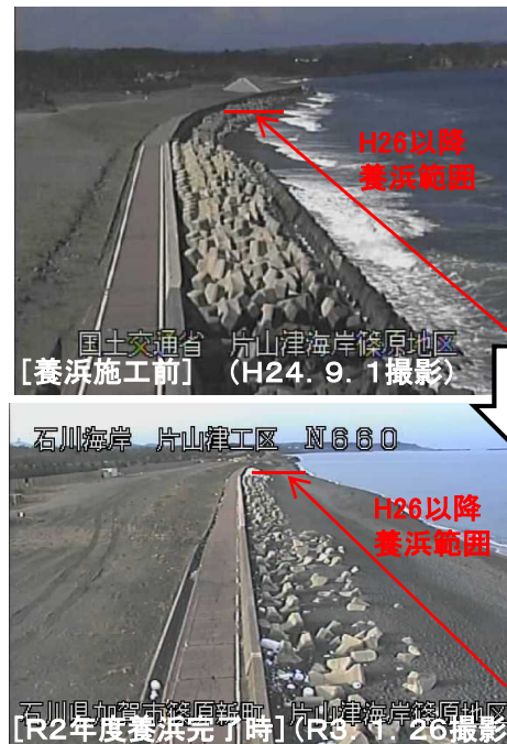
図2-2 片山津工区事業実施状況(消波工、養浜工) — 4 —
