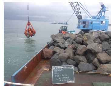
写真2-1 基礎部増大による材料費・海上輸送・作業の増 (海上輸送による材料調達)
