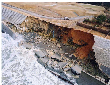
写真1-3 堤防決壊状況(平成12年1月小松工区)
