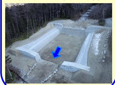
写真1-1 前回事業評価以降に完成した主な砂防設備
