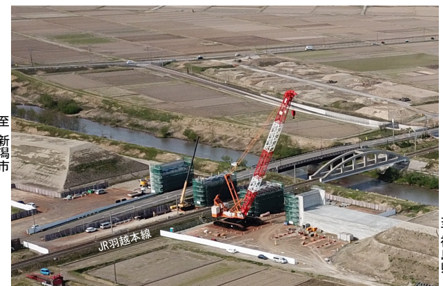
写真2-1 JR跨線橋架設状況 (R3年4月時点)
