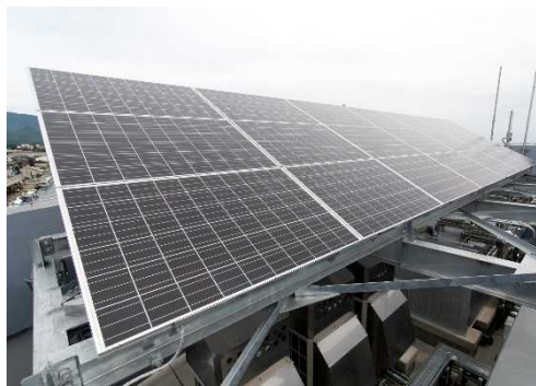
(太陽光発電設備の設置)
