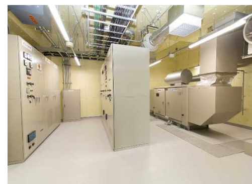
(電気室 設備スペースの確保)
