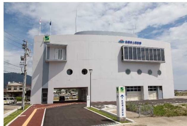
新庁舎全景写真
