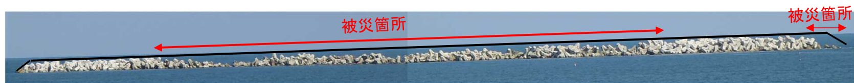
図2-1 台風第21号による第6防波堤の被災後の状況(平成29年10月撮影)
