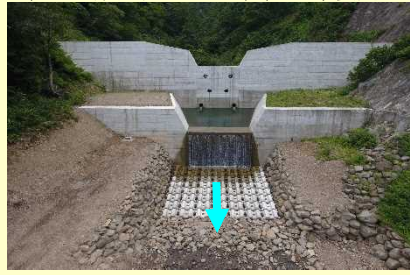
写真1-1 前回事業評価以降に完成した主な砂防設備
