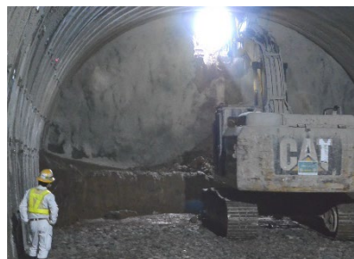
写真1 (仮称) 柏崎トンネル貫通
