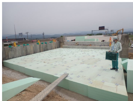
写真3-2 軽量盛土工法
