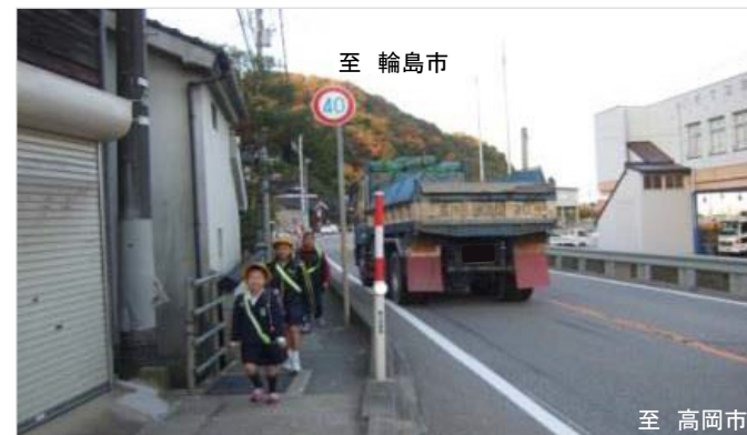
幅員の狭い通学路区間を通る大型車 写真⑤ 国道160号 石川県七尾市佐々波町地先
