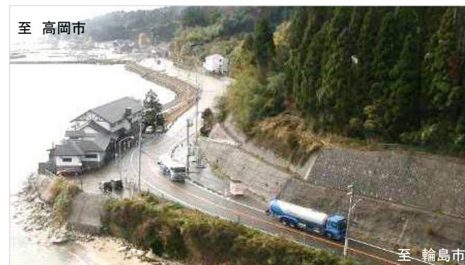
急カーブ連続区間 写真④ 国道160号富山県氷見市泊地先
