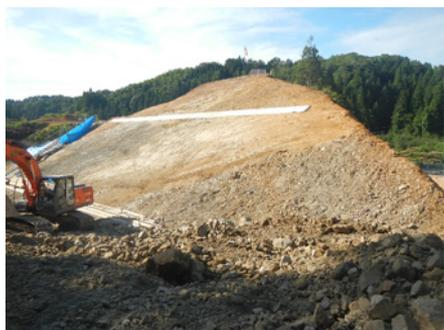
写真3-3 礫岩層の切土法面
