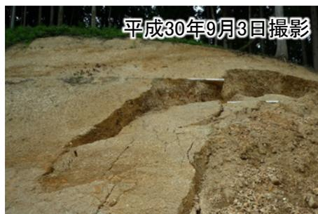
写真3-1 地滑りによる亀裂
