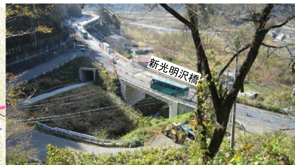
写真1-5 急カーブ区間を解消した新光明沢橋
