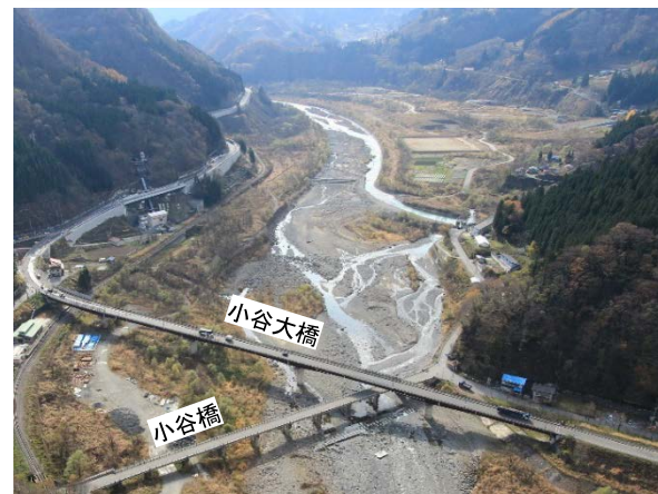
写真1-4 幅員が狭い小谷橋と新しく整備された小谷大橋
