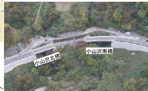
写真1-6 線形不良箇所を解消した小山沢北橋と小山沢南橋
