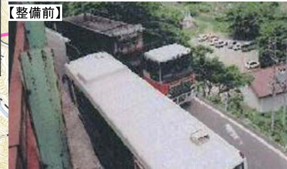
写真2-8 大型車のすれ違いが困難な箇所
