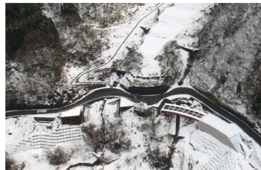
写真1-3 線形不良箇所
