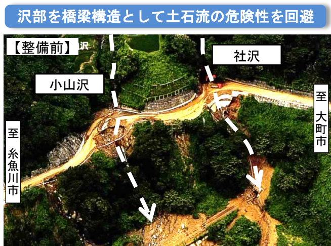
写真2-3 整備前(H7年7月豪雨災害の被災状況)
