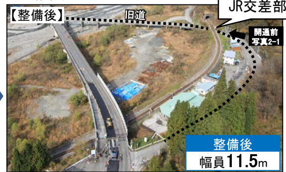
写真2-2 JR交差点を橋梁で回避(小谷大橋)
