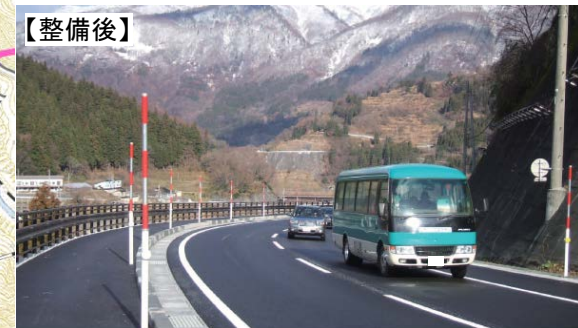
写真2-7 道路を拡幅して道路線形を改良したマムシ岩地先では、スムーズな交通が確保された。
