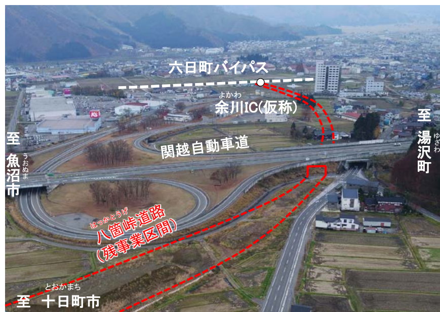
写真2-1 八箇峠道路残事業区間
