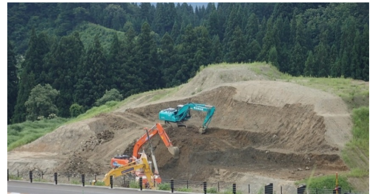
図3-5 八箇峠トンネル掘削土の盛土転用
