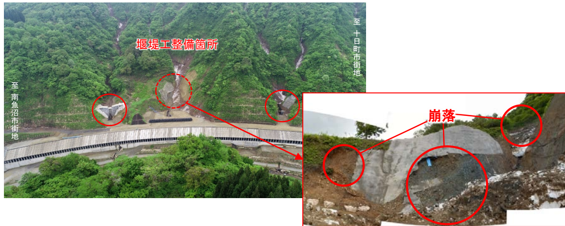
図3-4 堰堤工整備箇所 の法面崩落
