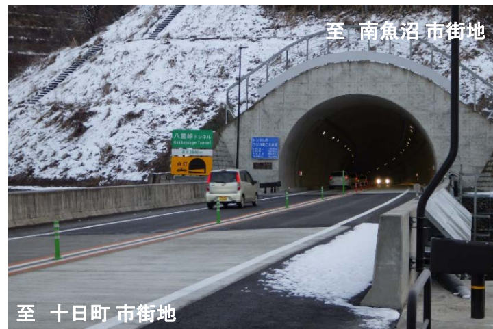
写真4-3 国道253号 八箇峠道路
