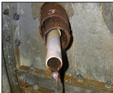
従来型:VP管<硬質塩化ビニール管>
