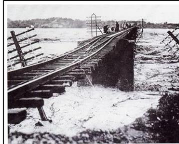
手取川鉄橋(濁流による洗掘)
