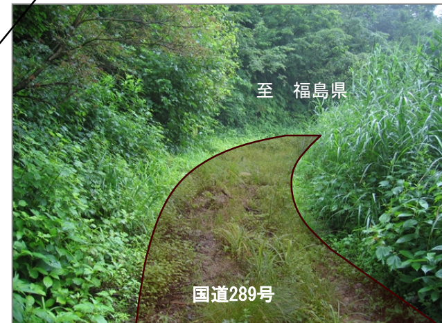
写真1 現況写真（通行不能区間現況）
