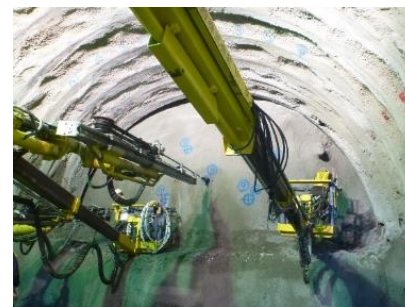
写真2 7号トンネル鏡補強工の状況
