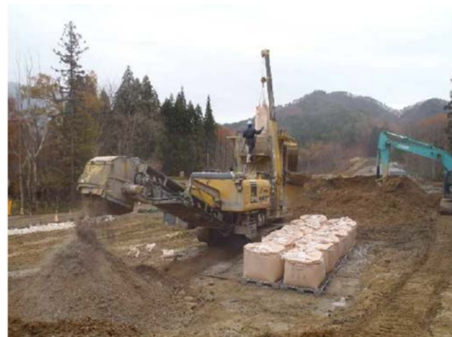
写真3-1 発生土の改良・施工状況
