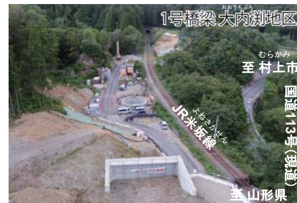
写真2-1 1号橋梁整備状況 (大内淵地区)
