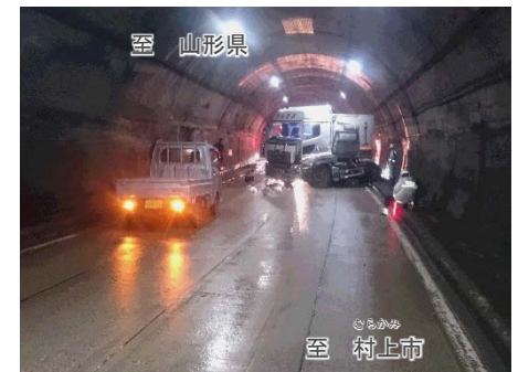
写真4-7 交通事故による通行止め (片貝トンネル内 H30.6.12)
