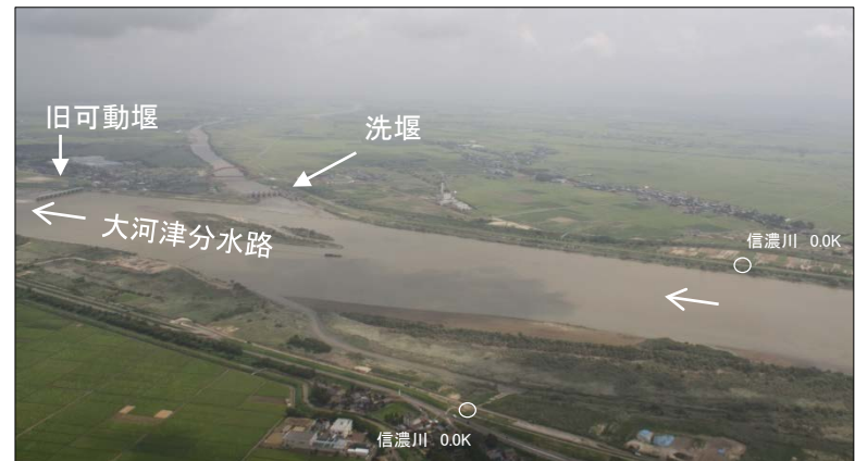
平成23年7月新潟・福島豪雨時の出水状況 (写真4-2)
