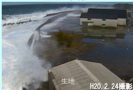
冬季風浪による高波被害時の状況 (平成20年2月)
