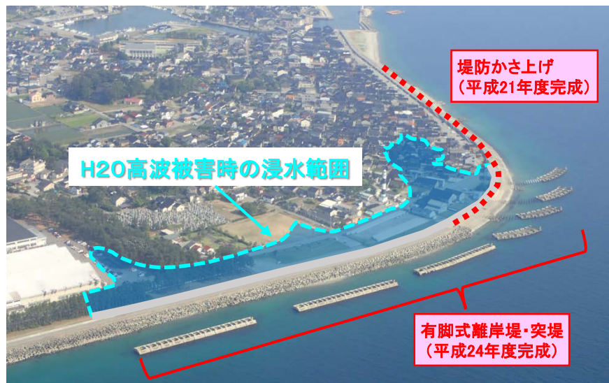
冬季風浪による高波被害（平成20年2月）の浸水範囲と対策状況 (黒部市生地地先) (写真2-3)
