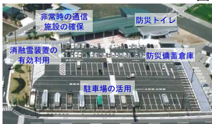
写真⑤ 道の駅「万葉の里高岡」の防災機能
