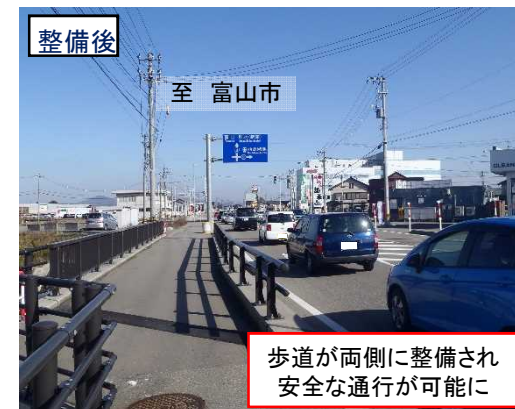
写真④ 国道8号中川橋(富山市方面を望む)
