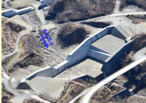
だしわらだに ①多枝原谷第28号砂防堰堤 〈湯川流域〉 平成27年度完成
