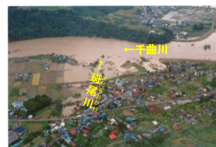
平成16年10月洪水時における 中野市替佐地区の浸水状況
