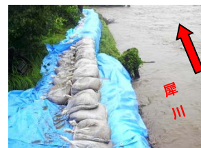
平成18年7月洪水時における犀川 の水防工法実施状況（安曇野市）
