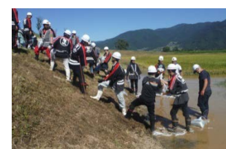
平成25年9月洪水時における千曲川 の水防工法実施状況（飯山市）
