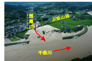
平成18年7月洪水時における 中野市替佐地区の浸水状況
