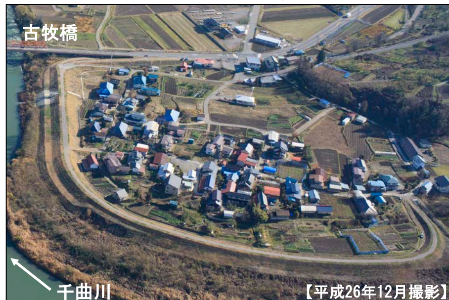
《輪中堤整備後の古牧地区の状況(写真5-2)》
