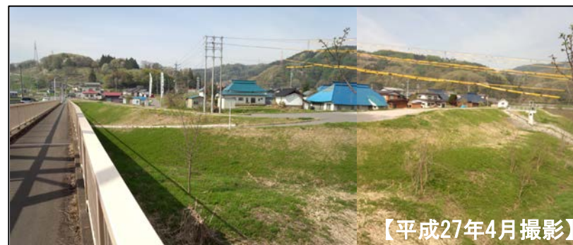
《輪中堤整備後の古牧地区の状況(写真5-3)》
