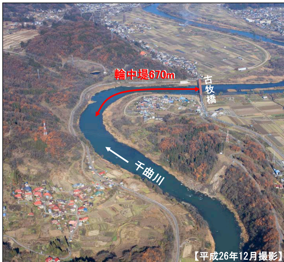
《輪中堤整備後の古牧地区周辺の状況(写真4-1)》
