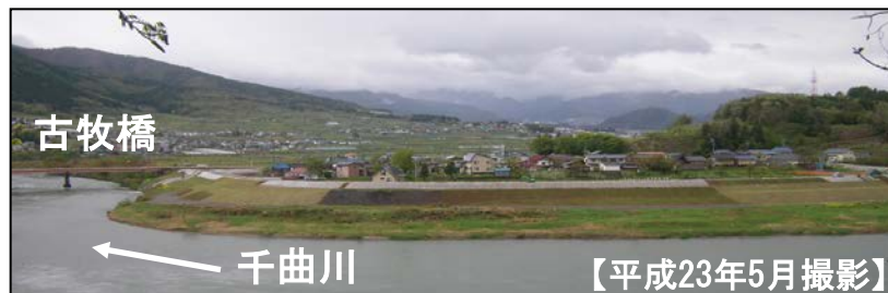
左岸側より右岸側を望む
