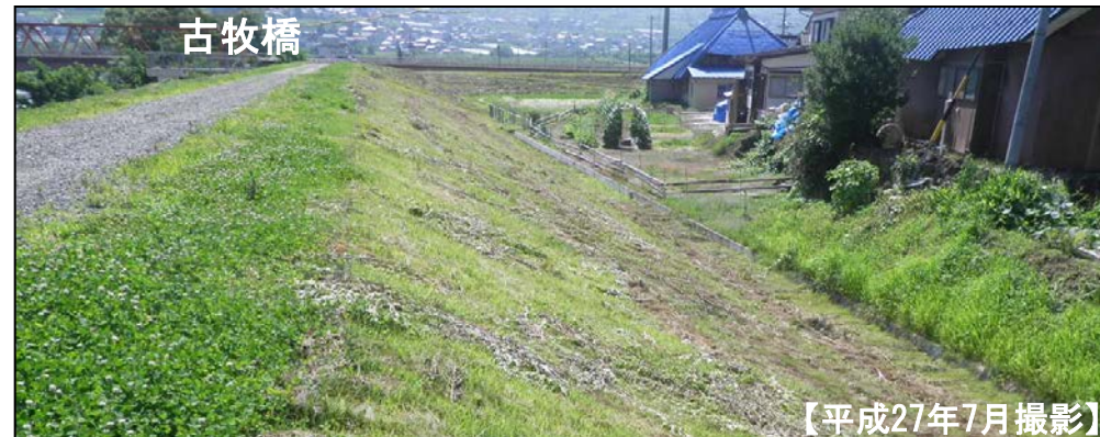
堤防上より下流方向を望む
