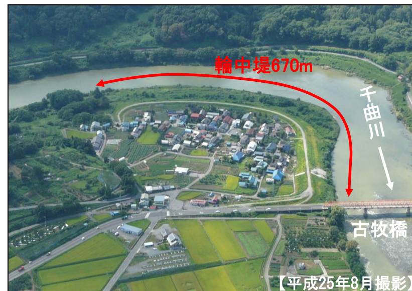
《輪中堤整備後の状況(写真3)》
