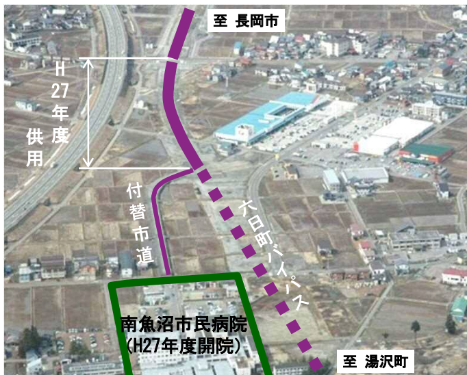
写真：湯沢町方面より供用区間を望む
