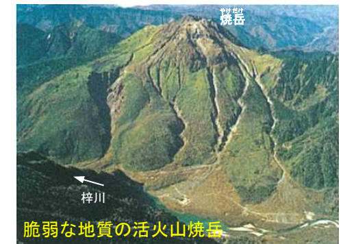
図1-3 上流部の荒廃状況
