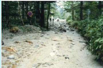
県道上高地公園線の土砂堆積状況
