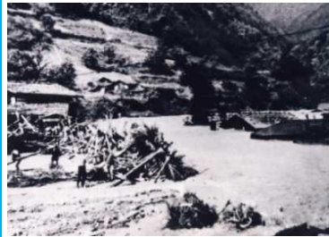
島々地区での土砂氾濫状況
