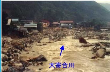
寄合渡地区での土砂氾濫状況
