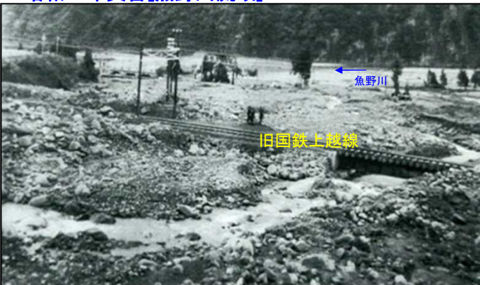
湯沢町付近の旧国鉄上越線の被害状況
