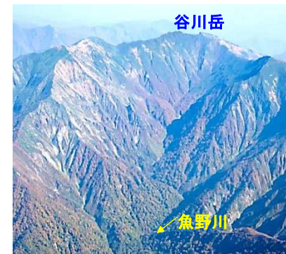
図1-3 源頭部の荒廃状況
