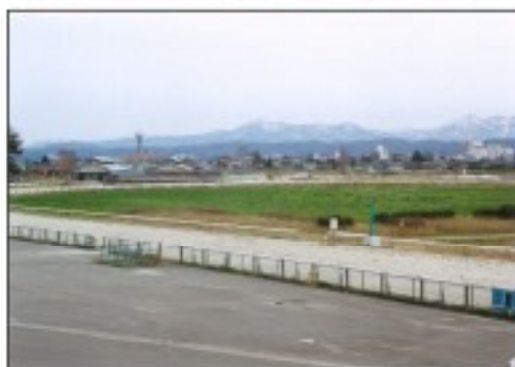
交流広場や船着場がなく散策路が舗装もされていないため、利用しにくい状況
