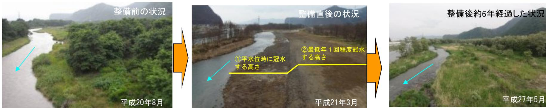
写真①-5 平成20年度に整備（試験掘削）箇所の整備前・整備直後・整備後約6年経過した状況（鼠地区）
