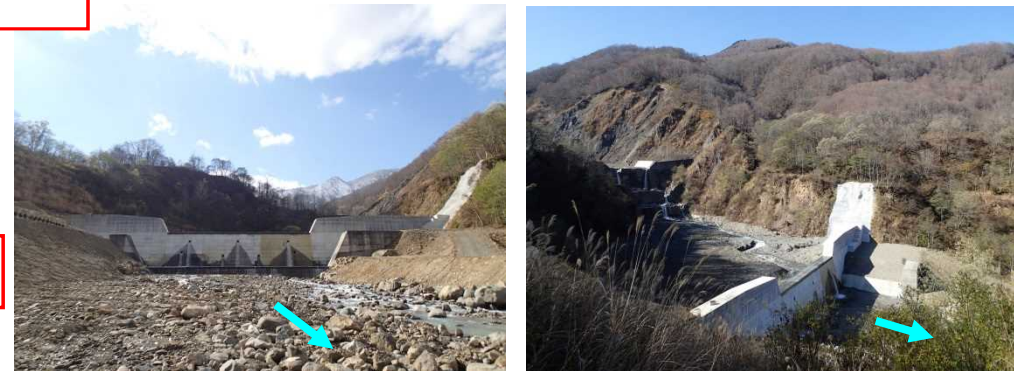
図2-5 浦川下流第1号上流砂防堰堤補強【平成26年度完成】 左:下流より 右:右岸側より
