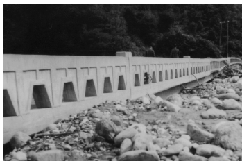
土石流により埋没した水神宮橋
