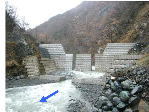
図2-4 小滝第1号砂防堰堤【平成25年度完成】
