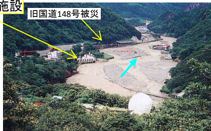
被災状況 姫川温泉付近
