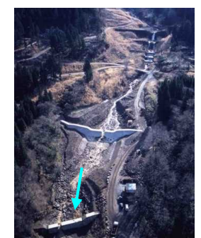
■根知川流域 砂防堰堤等により河床に堆積した不安定土砂の流出を防止。
