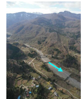
■浦川流域 砂防堰堤等により荒廃地からの土砂の流出を防止。
