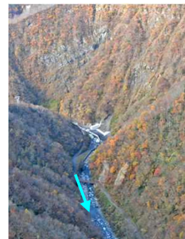
■小滝川流域 砂防堰堤等により河床に堆積した不安定土砂の流出を防止。
