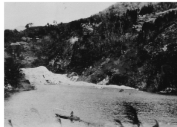
大崩壊により形成された天然ダム
