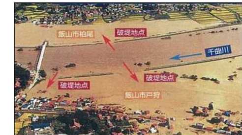
飯山市柏尾・戸狩地先本川破堤状況
