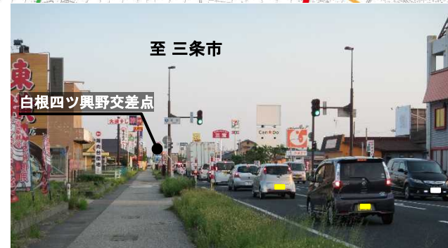
写真②：国道8号未整備区間の混雑状況 （白根四ツ興野交差点付近）
