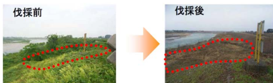
図 4.2.15 庄川における樹木伐採状況（雄神大橋下流）
