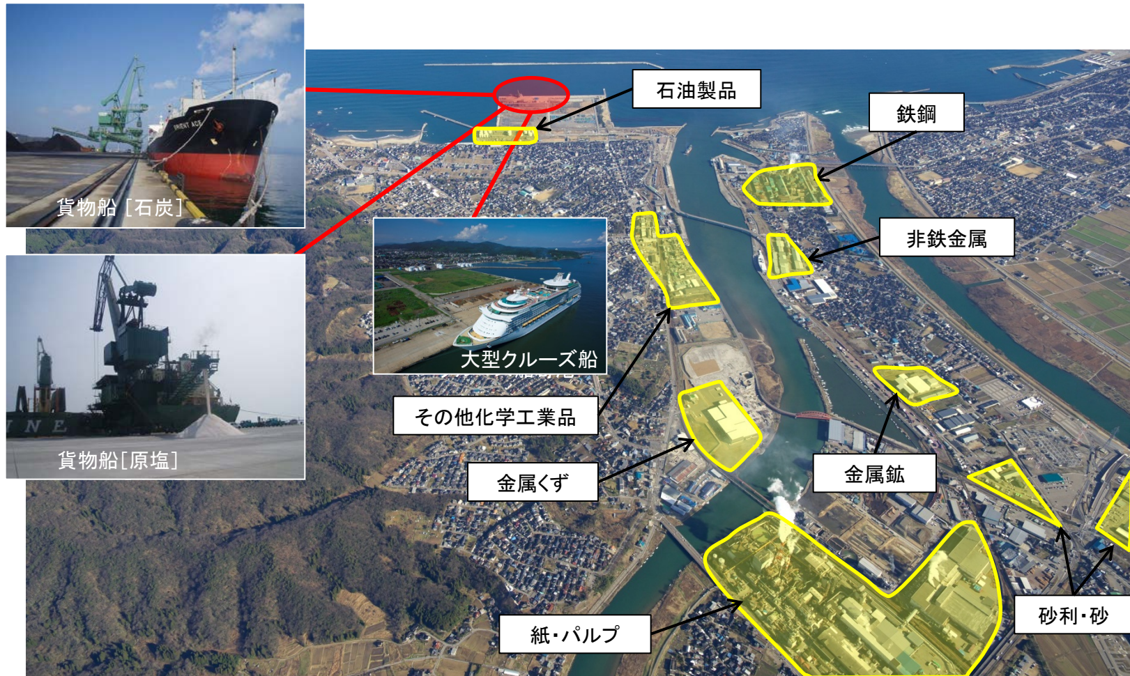
図1-2 伏木富山港(伏木地区)の概要
