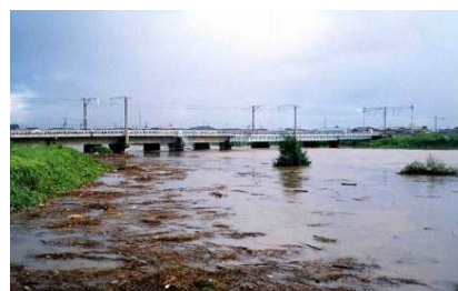
写真①：平成10年9月の梯川の増水状況
