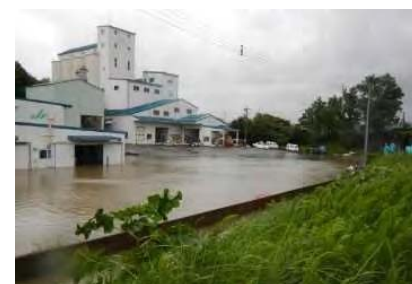
写真③：平成25年9月の梯川の内水氾濫
