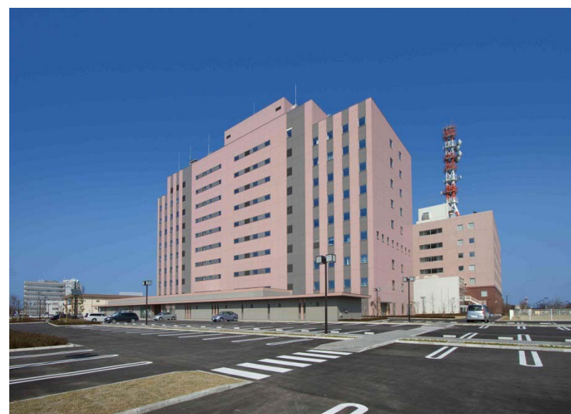
【新潟第2地方合同庁舎（Ⅱ期）の整備状況（南西面全景）】
