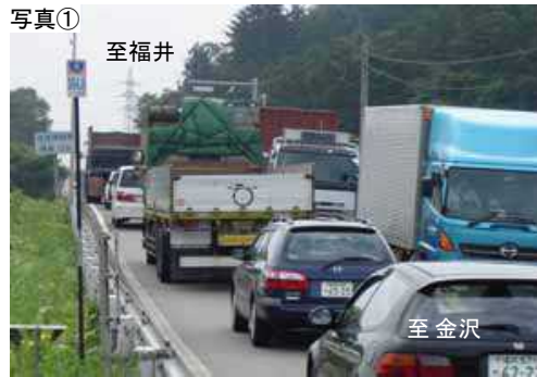
【整備前の交通状況】
