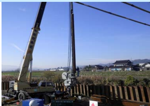
新技術による仮締切鋼矢板打設状況
